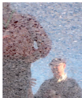
Polerowanie betonu (Crystal finish)
