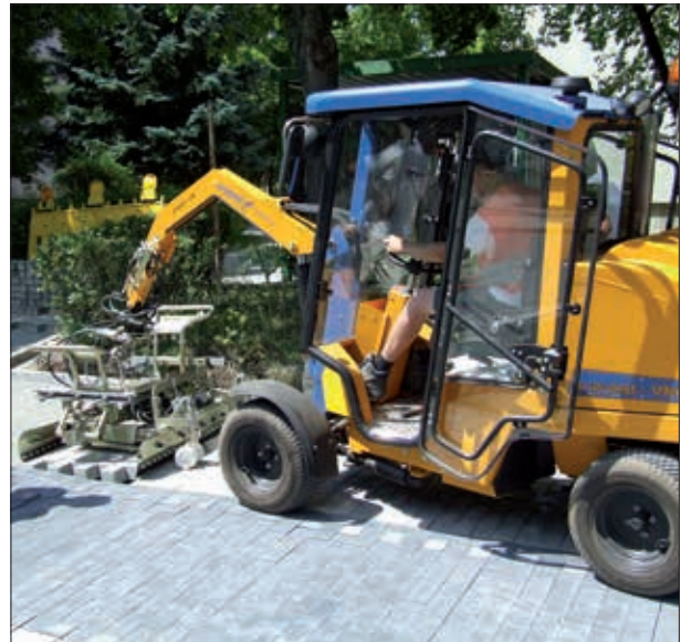
Maszyna do mechanicznego układania kostki VM-301-K-PAVERMAX z kabiną i chwytakiem HVZ-UNI
