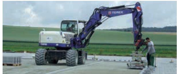
HVZ-GENIUS zainstalowany na koparce obrotowej
