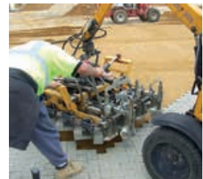
HVZ do układania kostki w „jodełkę” pod kątem 45 stopni
