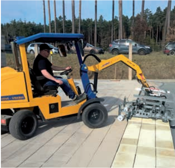
Maszyna do mechanicznego układania kostki VM-301-PAVERMAX with HVZ-UNI-II
