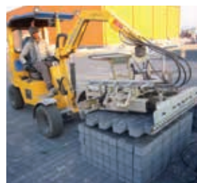
VM-203: Układanie prostokątnej kostki brukowej z przesunięciem
